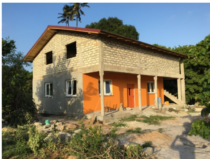
Das neue Doktorhaus mit seinem fröhlichen Außenanstrich im Sonnenlicht
