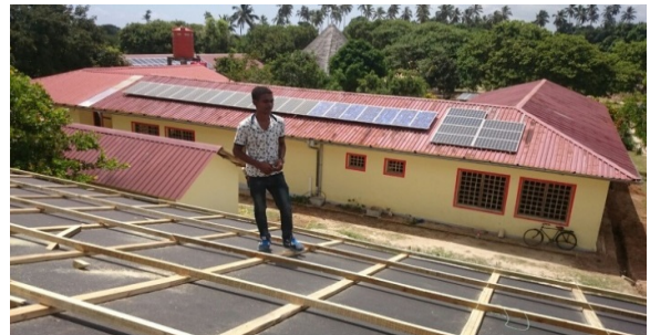
Blick vom Dach des Doktorhauses auf das Schulgelände und unser Bauleiter
